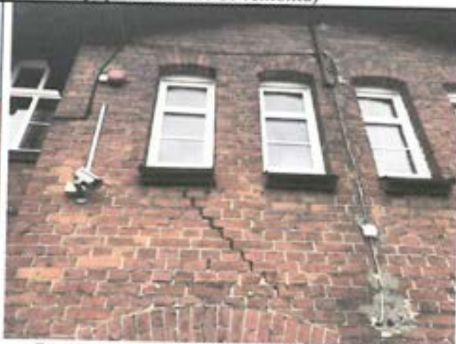
Fot.2. Widoczne pęknięcie w ścianie – zalecana naprawa
