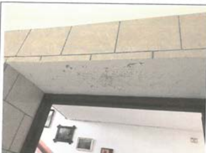
Fot.11. Wykonać naprawy tynków nad wejściem do toalety na parterze budynku w części po byłej szkole
