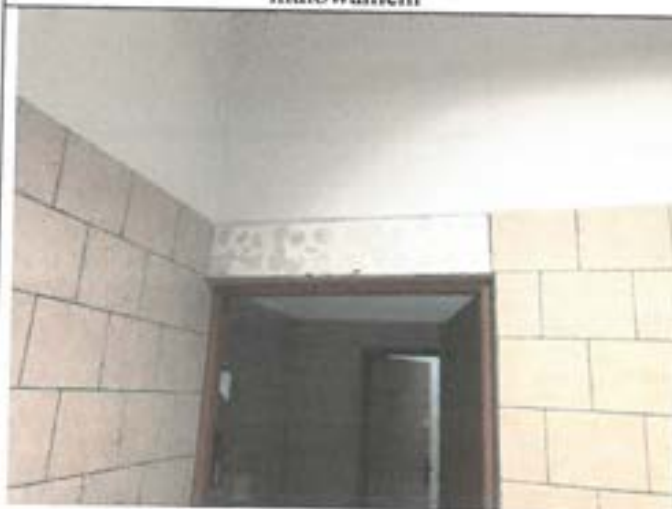
Fot.9. Uzupełnić okładziny ściany w toalecie na parterze budynku
