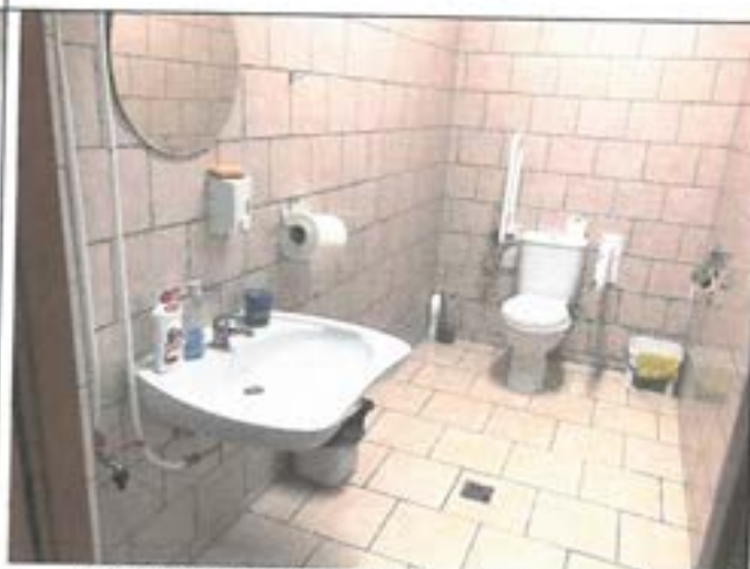
Fot.10. Toaleta dla osób niepełnosprawnych - dostosować wyposażenie toalety poprzez: zainstalowanie instalacji przyzywowej oraz montaż uchwytów w obrębie umywalki
