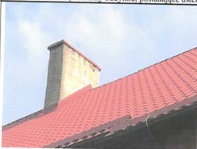
Fot.1. Zalecana naprawa tynków na kominie powyżej dachu
