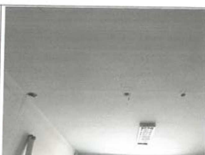
Fot.12. Wykonać naprawy tynków na suficie po demontażu krat w części po byłej szkole
