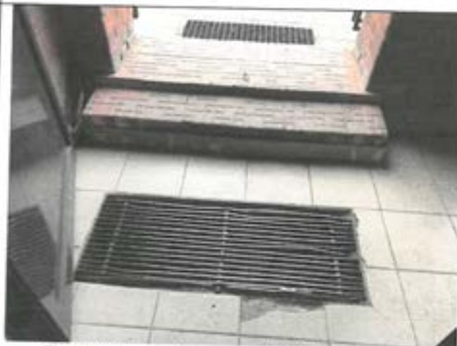
Fot.4. Wykonać naprawy okładzin w obrębie wycieraczki na klatce schodowej przynależnej do dawnej szkoły
