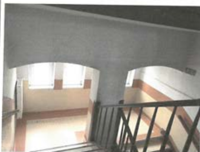
Fot.13. Widoczne zabrudzenia ścian na klatce schodowej w części po byłej szkole – zalecane malowanie ścian
